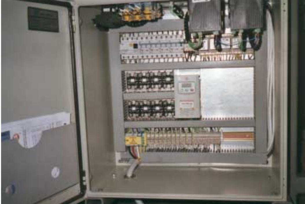
Steuerschrank mit Frequenzumrichter, Temperaturregler und Halbleiterrelais für den Leistungsteil der Heizungen.
